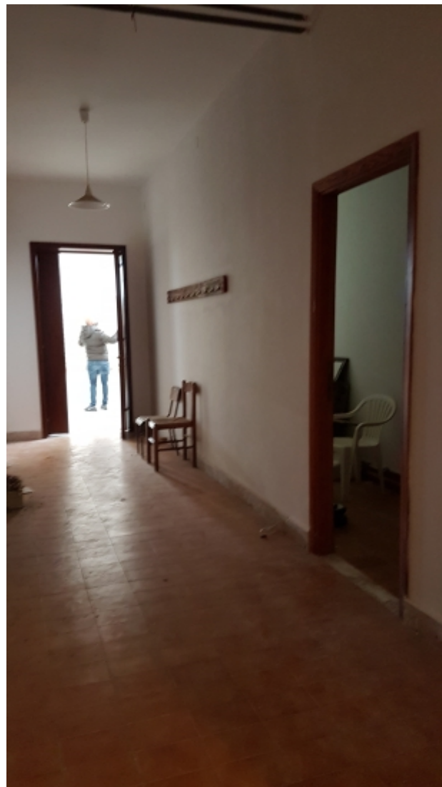
foto 8. ingresso all'andito secondario in cui ricavare locale tecnico
