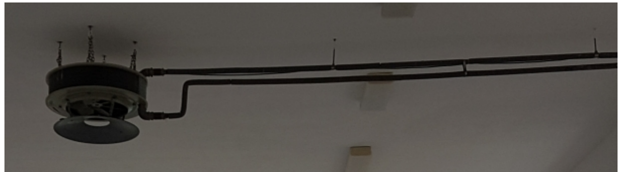
foto 11. vista sulla palestra e dettaglio tubazione impianto esistente
