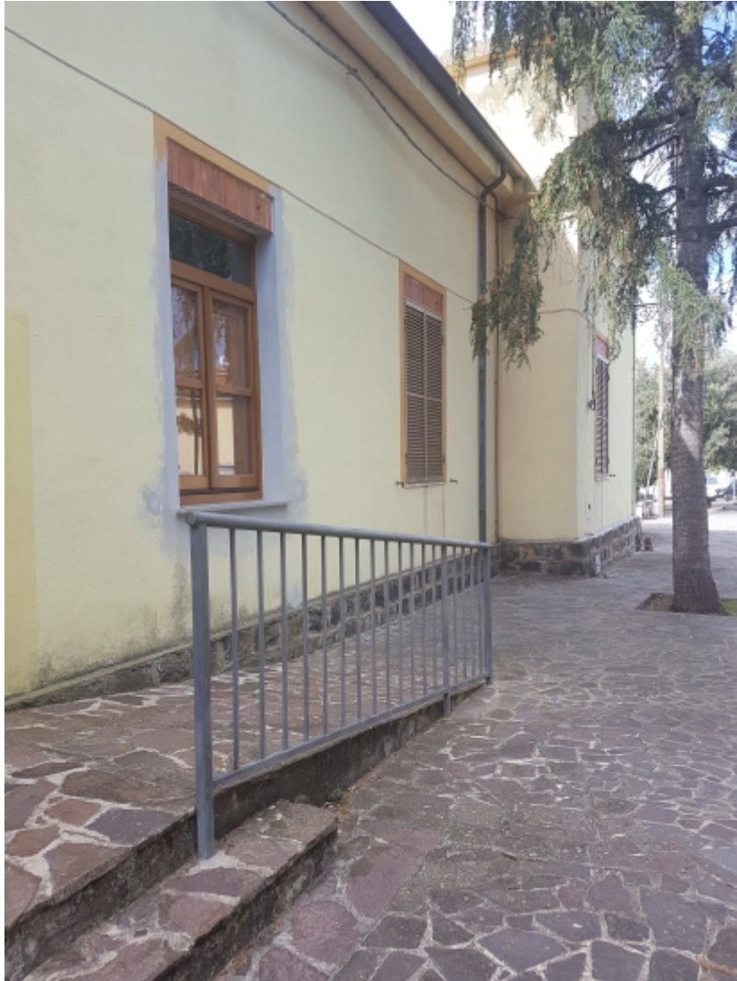
foto 1. rampa e gradini di ingresso
