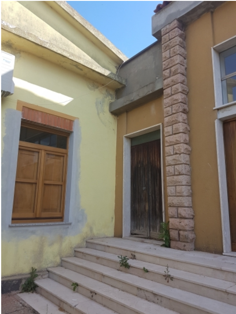
foto 10. vista esterna del vano di accesso al futuro locale tecnico
