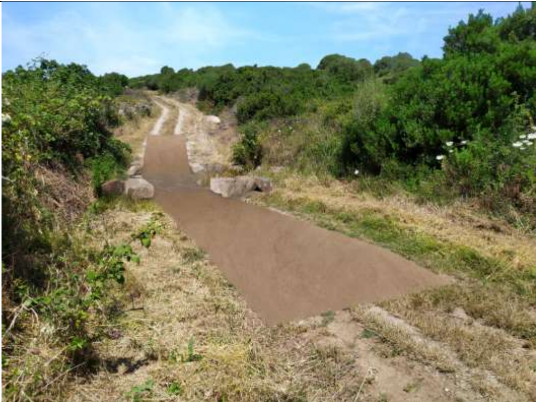
Scatto 1 – veduta intersezione a guado da lato Nord – Post intervento
