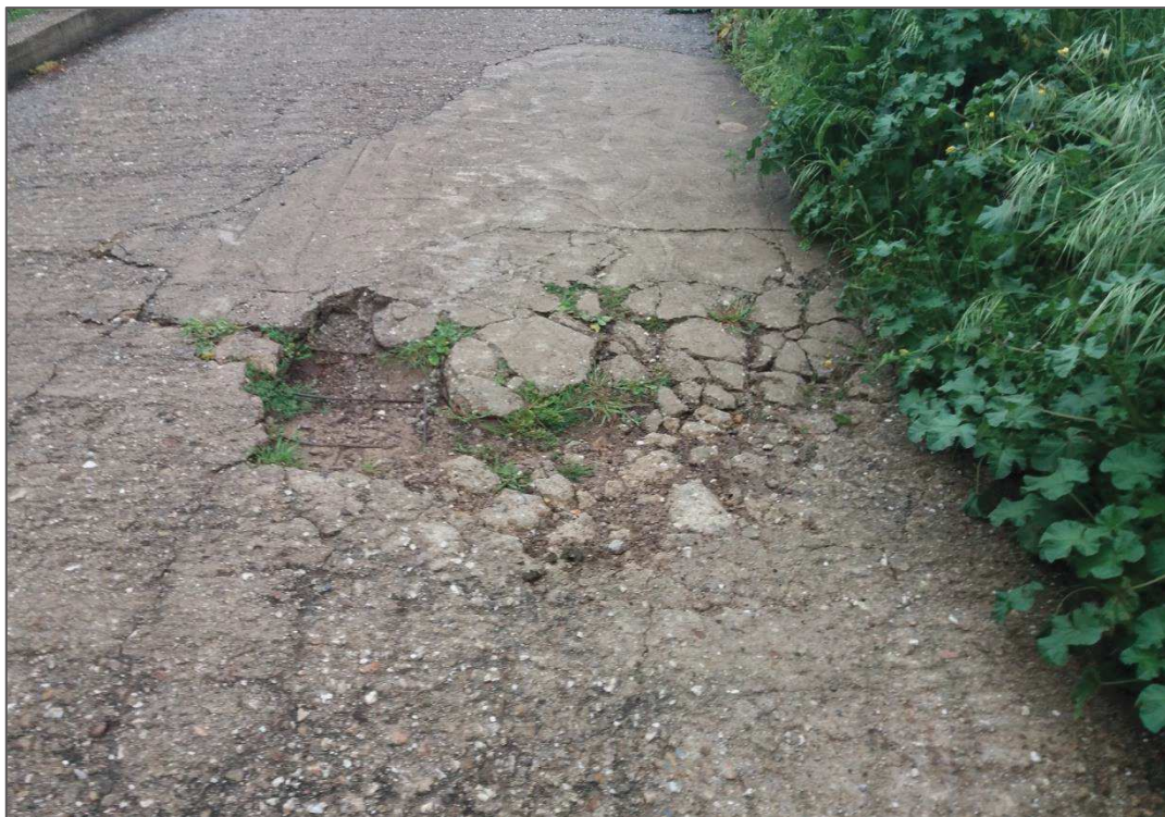
Figura 4_Dissesto della pavimentazione in conglomerato cementizio armato
