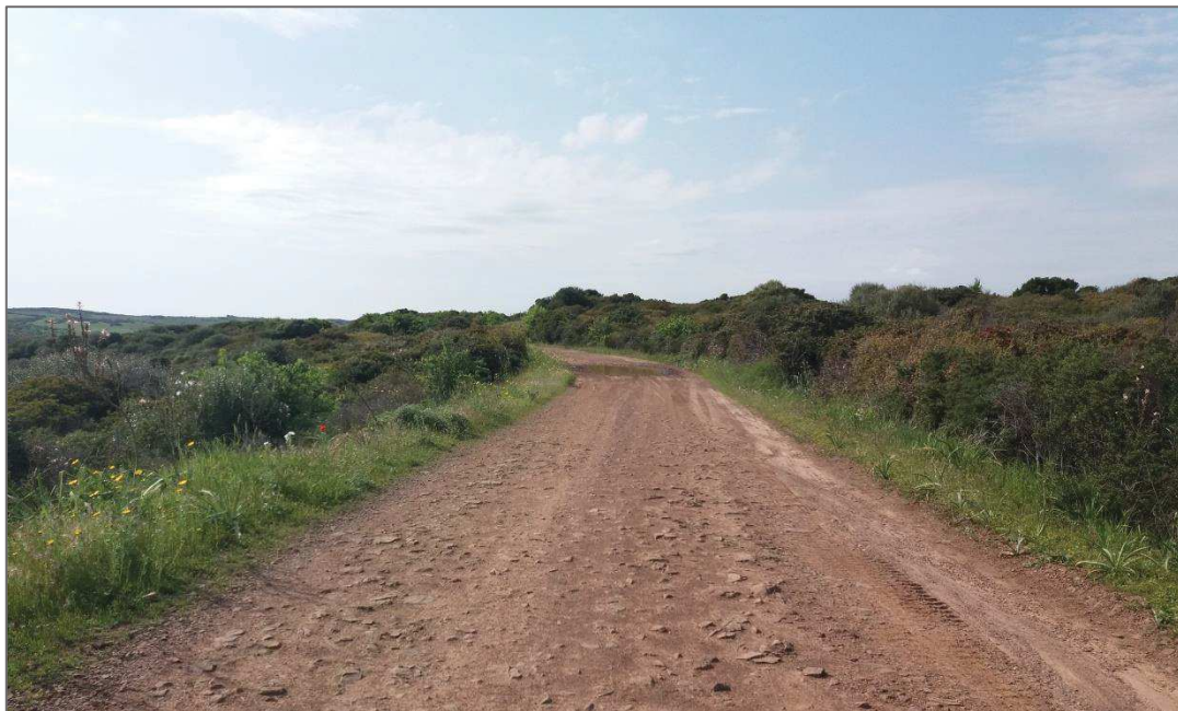
Figura 3_Stato attuale del tratto di strada da pavimentare
